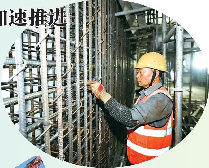
▲9月1日,中铁二十局工人在石家庄市地铁5号线一期03工区施工现场捆绑钢筋。
