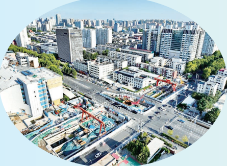
石家庄市地铁5号线一期工程建设现场(9月1日报,无人机照片)。
